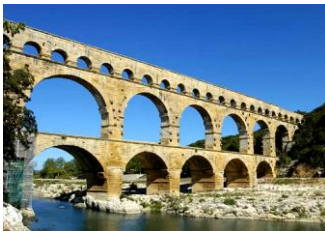
ガール水道橋
